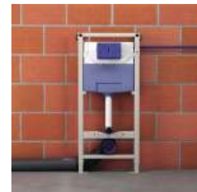
3 Подсоедините инсталляцию к водоснабжению и сливу. Установите защитные короба.
